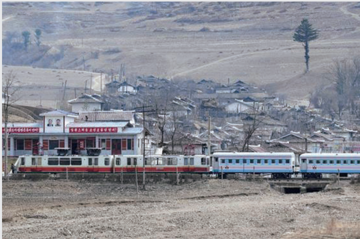
〈북한 자강도 만포시 심리동리에 위치한 북부내륙선 기차역인 심리동역 앞에 기차가 서 있는 모습〉
