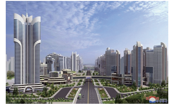
평양 사동구역 송신·송화지구 살림집 전경 (출처: 데일리 NK)
