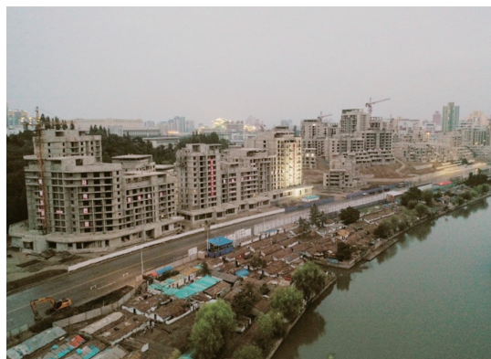
보통강구역에 건설중인 아파트 공사 현장. 보통강구역에는 중앙당 고위 간부들이 다수 거주중인 것으로 알려졌다. (사진 출처: Daily NK)
